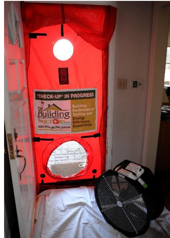
Blower Door Test
